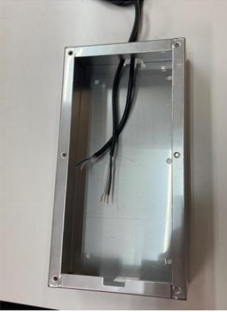
ボックス内に信号線、電源線を引き込む。
